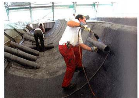
Soudage des lés bitumineux
