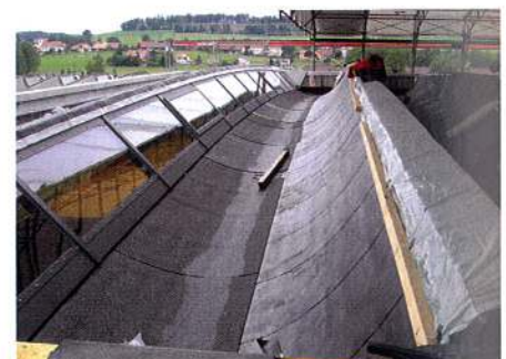
Pose de lé bitumineux
