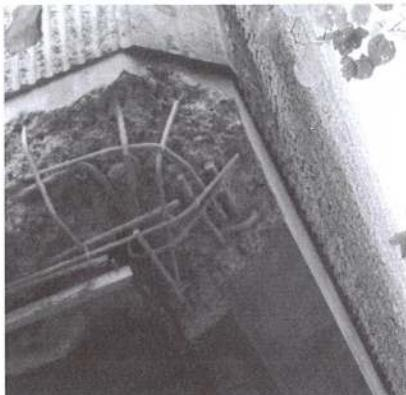
Après examen approfondi de la couverture des fers d'armature et de la qualité du béton, il a été procédé, pour les deux objets, à l'assainissement du béton proprement dit, soit:
