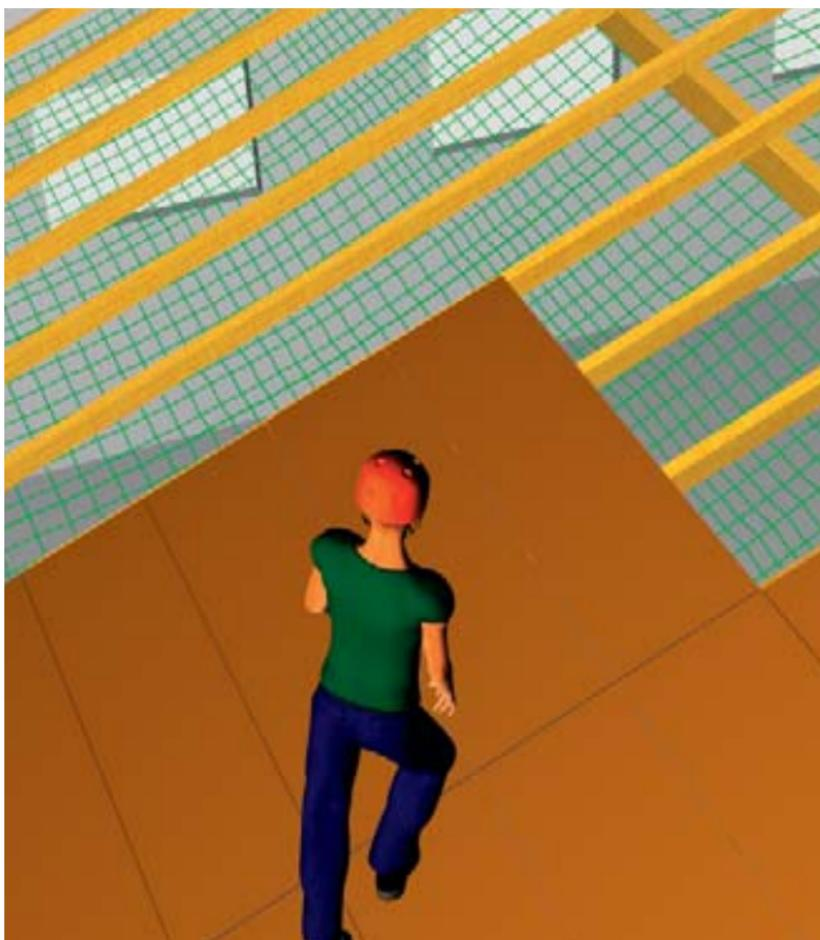
**Travailleur:** Je ne monte des éléments de toiture que si des filets de sécurité ou des échafaudages de retenue sont installés sur toute la surface.
