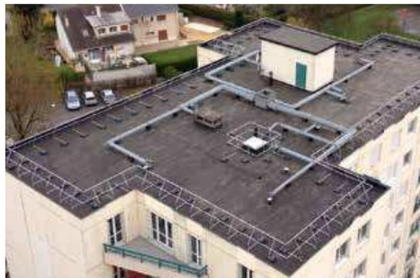
Le système de garde-corps autoportant en aluminium garantit la sécurité lors de travaux de maintenance et d'entretien sur des toitures non accessibles au public. Barrial autoporté satisfait parfaitement toutes les exigences légales en matière de protection collective permanente contre les chutes.
