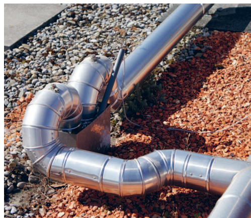
Installation thermosolaire: pose de la conduite, traversée du toit ouverte (à gauche) ou couverte (à droite)
