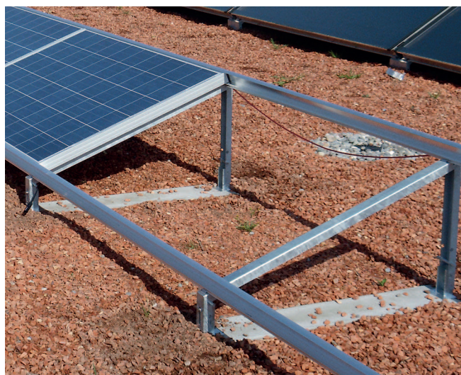
Pose des supports pour toits plats plats sur une plaque de répartition de pression (socle en béton)
