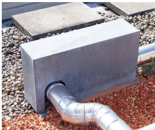
Installation thermosolaire: pose de la conduite, traversée du toit ouverte (à gauche) ou couverte (à droite)
