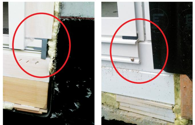
Fig. 19: Les passages non étanches et à surfaces décalées avec changement de matériaux doivent être exécutés selon le chapitre 10
