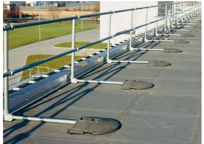
Fig. 16: Classe d'équipement 3: Système de protection latérale avec poids de retenue
