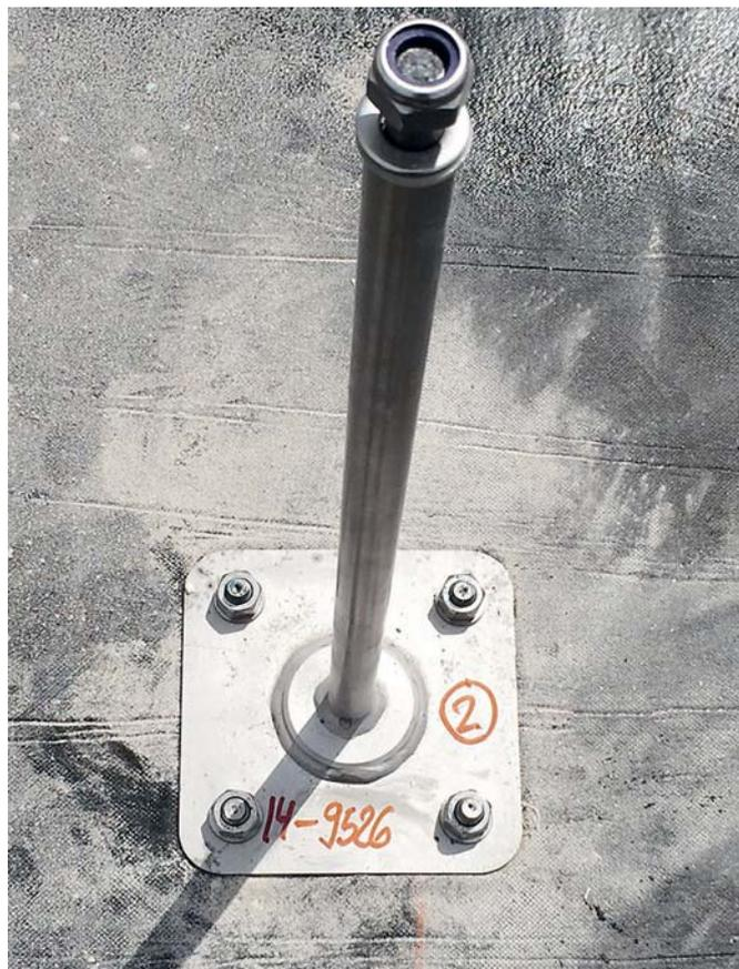
Fig. 23: Le point de fixation monté et marqué pour la photo de procès-verbal avec l'année, le numéro d'ouvrage du fabricant et d'un numérotage continu
