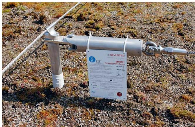
Fig. 24: Marquage d'installation spécifique à l'ouvrage
