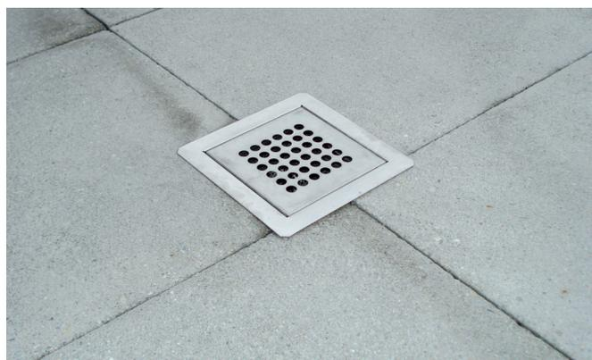
Fig. 17: Naissance d'eau pluviale : grille perforée
