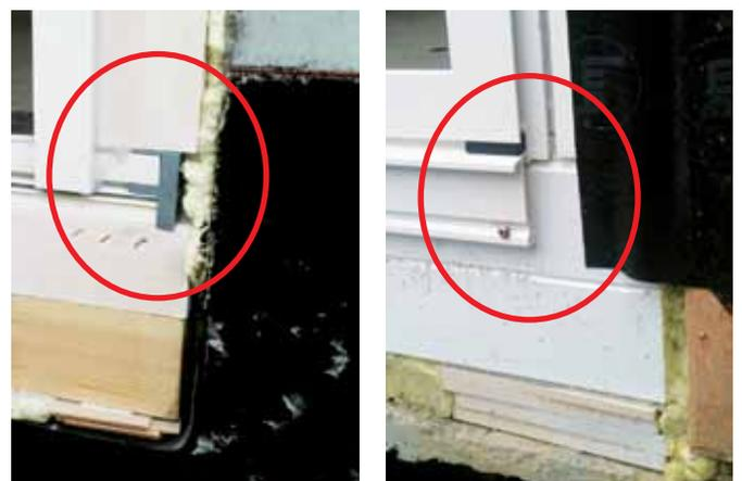
Abb. 19: undichte und flächenversetzte Übergänge mit Materialwechsell müssen gemäss Kapitel 10 erstellt werden
