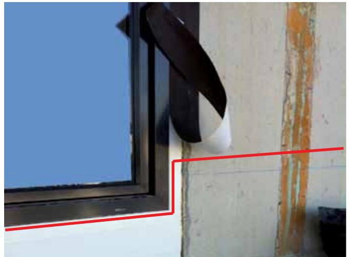
Abb. 20: Winddichtungs- oder Schlagregendichtungsbänder im Flachdachanschlussbereich hochklappen
