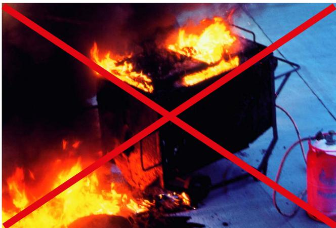
Abb. 22: Negatives Beispiel eines Bitumenofens, der in Brand geraten ist, ohne Überlaufwanne und ohne 3 m Sicherheitsabstand der Gasflasche.
