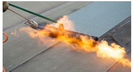
Abb. 20: Arbeitsausführungen mit verschiedenen Brennaufsätzen mit offener Flamme.
