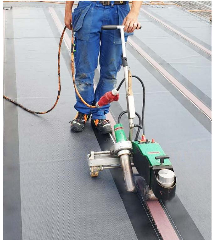
Abb. 4: Verschweissen mit Heissluft z.B. Verschweissung der Überdeckung 1-Lage bituminös
