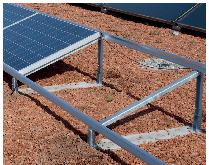
Einbau der Flachdachaufständerung auf einer Druckverteilungsplatte (Betonsockel)
