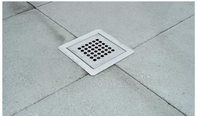
Abb. 17: Dachwassereinlauf: Lochrost
