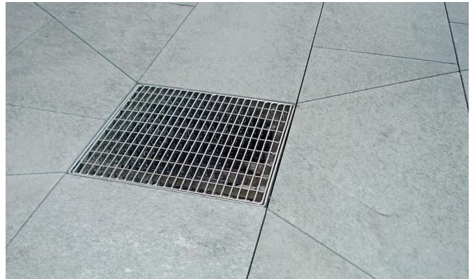
Abb. 16: Dachwassereinlauf: Gitterrost
