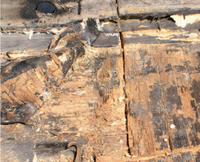
Abb. 3: Schadensbild Sekundärkondensat durch Restfeuchtverlagerung
