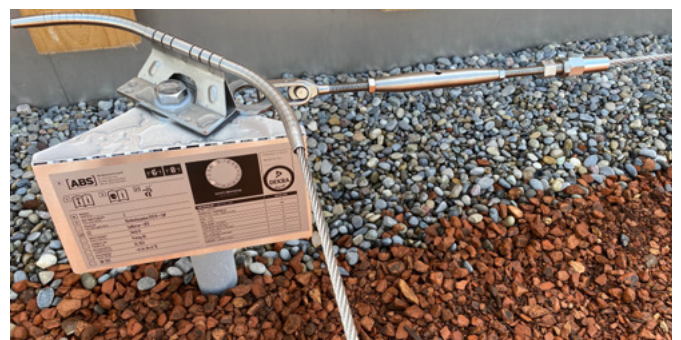
Fig. 43: Marquage spécifique à l'objet d'une installation de cordes
