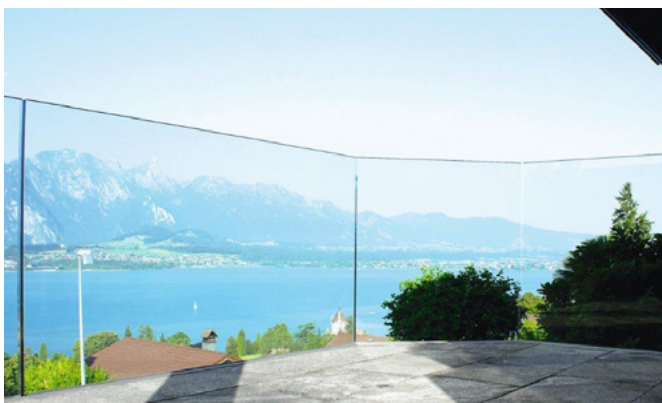
Fig. 26: Classe d'équipement 4 pour les toits plats accessibles au public
