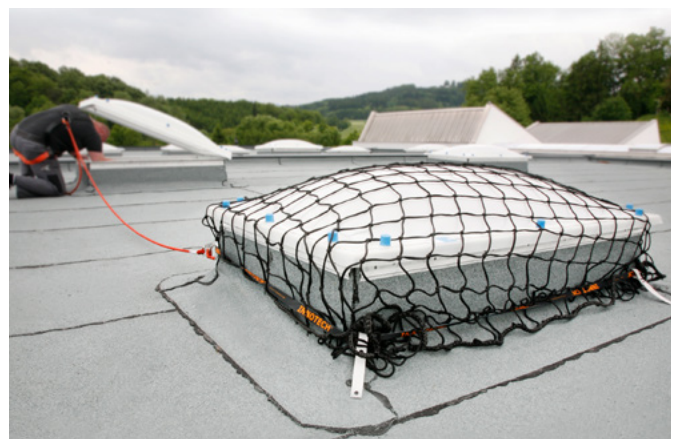
Fig. 39: Sécurisation temporaire d'une coupole de toit
