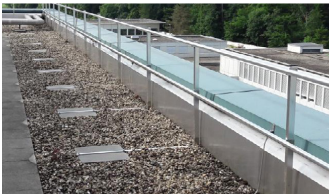
Fig. 24 Classe d'équipement 3: système de protection latérale monté avec des poids de retenue au sol
