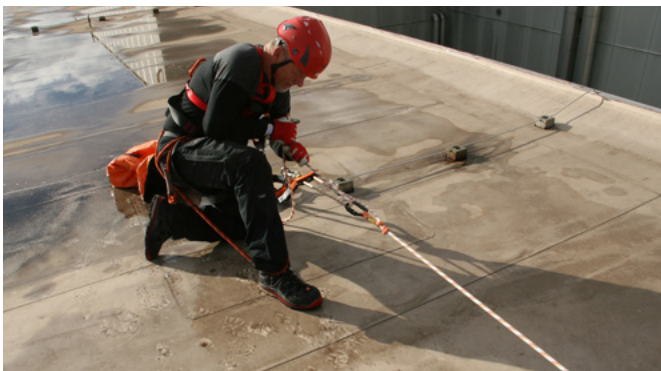
Fig. 10: Système temporaire à corde (ligne de vie) avec mousqueton fixé au PAI
