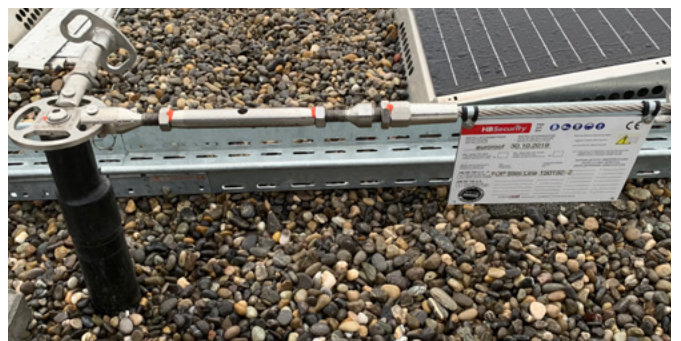
Fig. 42: Marquage spécifique à l'objet d'une installation de cordes
