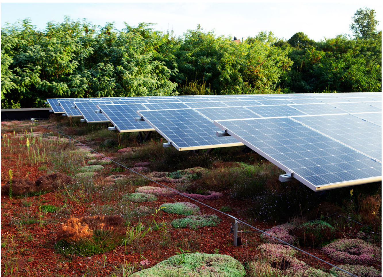
Abbildung 1: PV-Anlage kombiniert mit Extensivbegrünung, Quelle: contec
