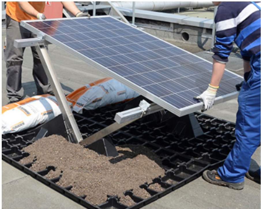
Abbildung 6: Auflastsystem für PV-Aufständerung, Quelle: Bauder
