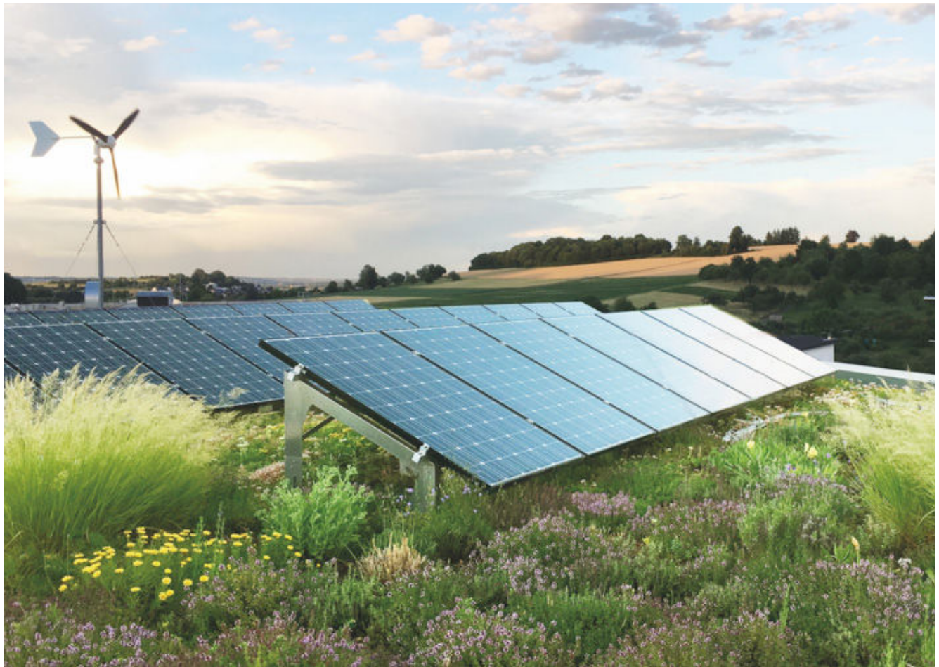
Abbildung 10: Kombination Intensiv-/Extensiv-Dachbegrünung neben PV-Anlage, Quelle: Zinco
