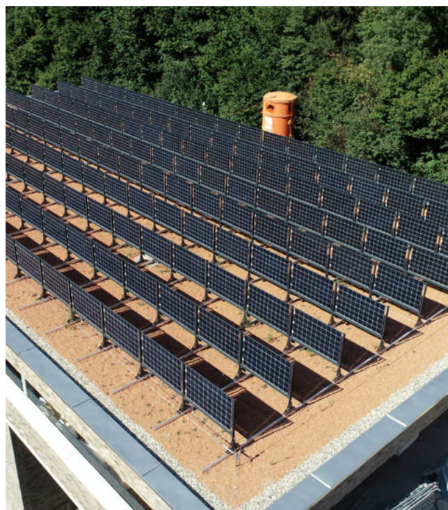
Figure 4: L'installation PV doit être installée à une distance suffisante du bord de la toiture ( \geq 60 cm), source: reech gmbh
